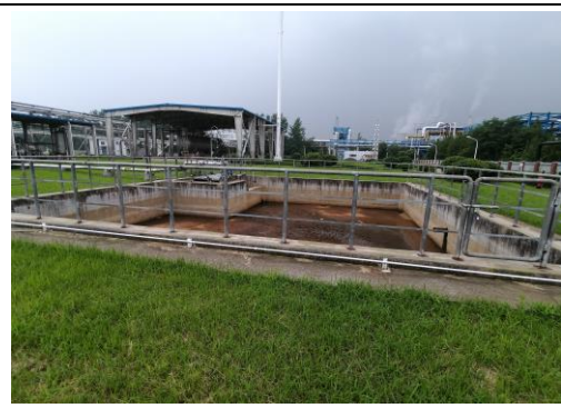
EO（环氧乙烷）储罐事故池
