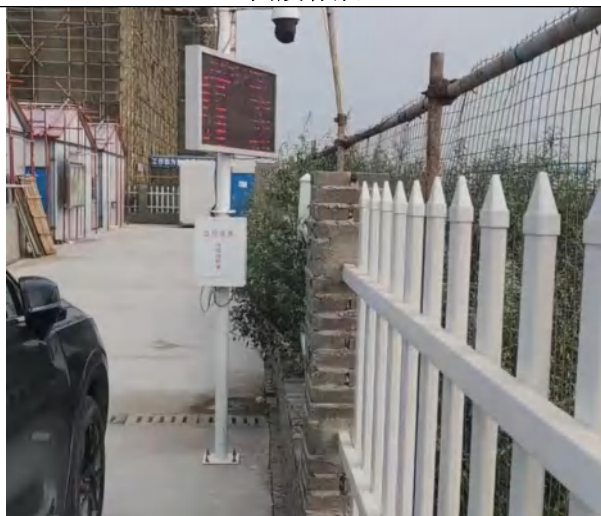
扬尘、噪声在线监控系统
