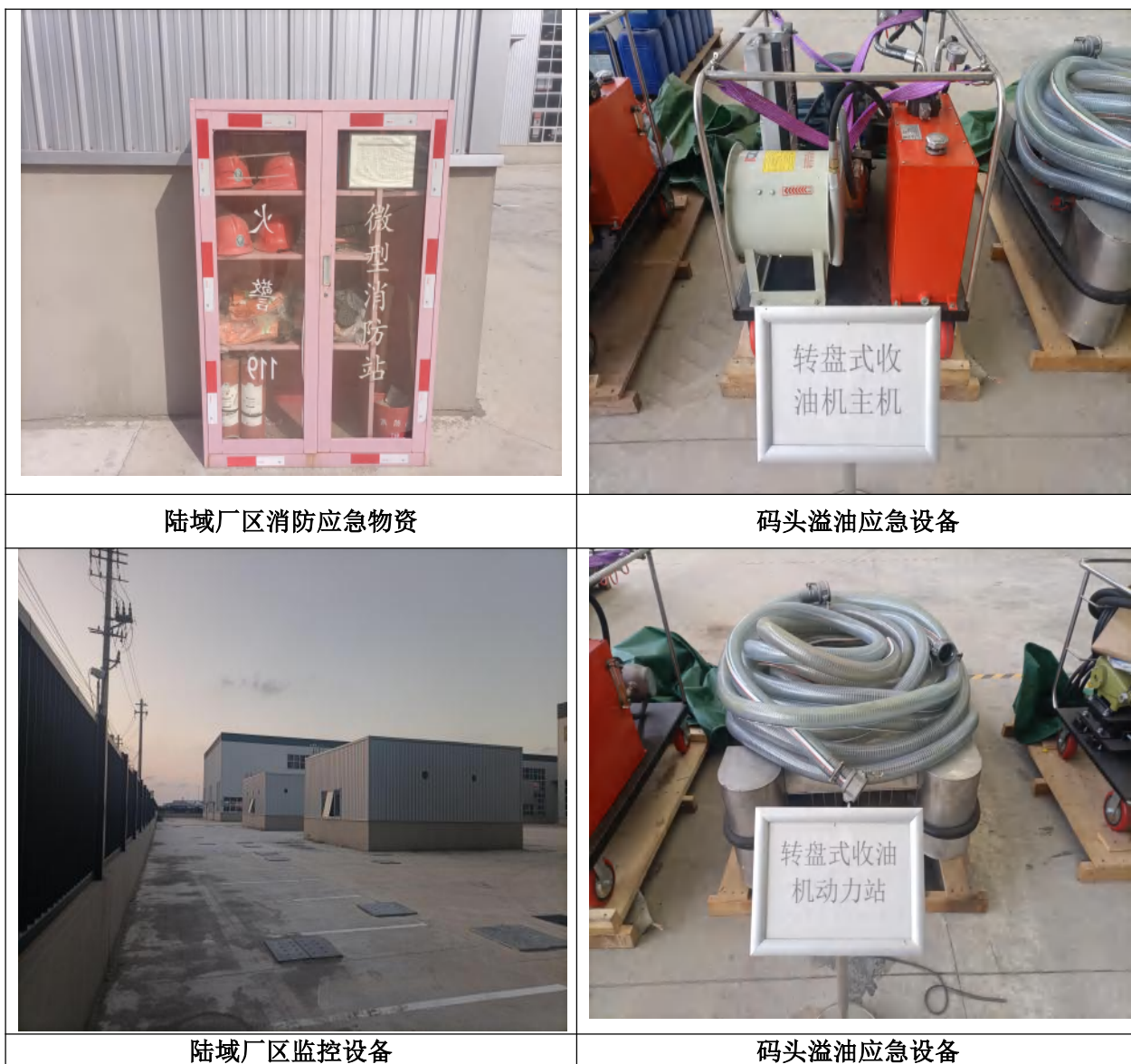
图 3.4-4 公辅工程实际建设情况
