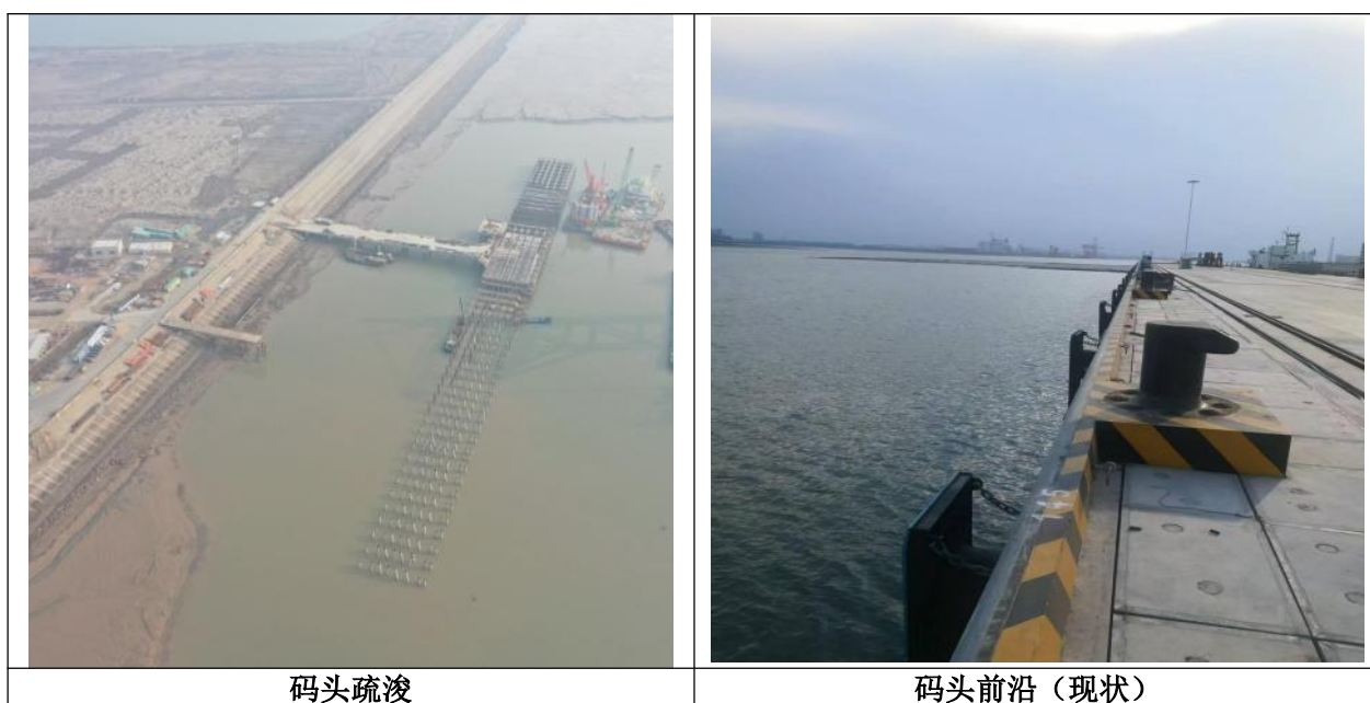
图 3.4-7 疏浚工程实际建设情况
