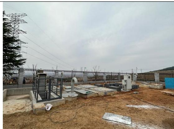
图 6.12 陆上集控运维中心地埋式污水处理设施
