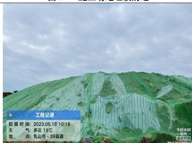
图 6.4 施工现场护坡绿网覆盖
