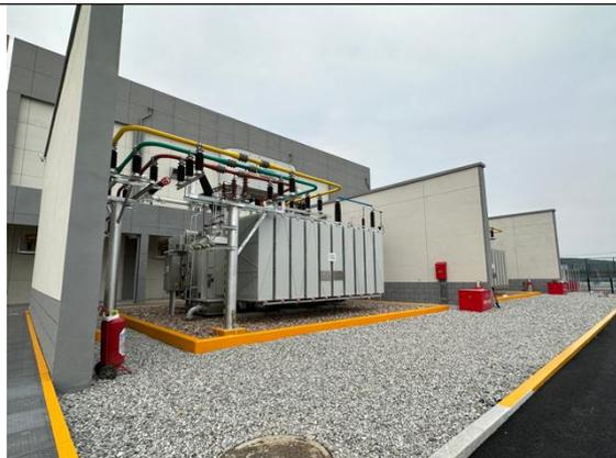
图 6.16 主变周围设置实体围墙
