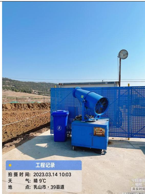
图 6.6 陆上集控运维中心施工现场防尘雾炮
