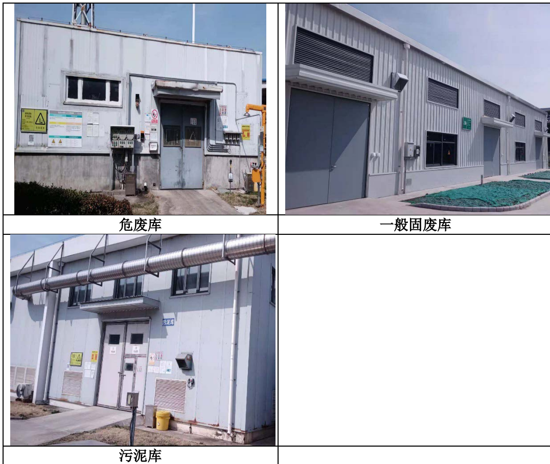
图 3-1 亚什兰现有危废库、一般固废库及污泥库现场情况
